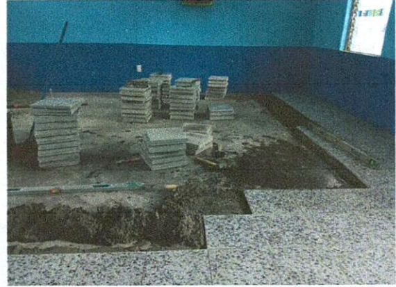
Foto 2: Mejoramiento de piso de tres aulas del nivel preprimario.
