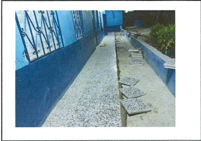
Foto1: Mejoramiento de piso en el corredor que abarca las tres aulas del nivel preprimario.
