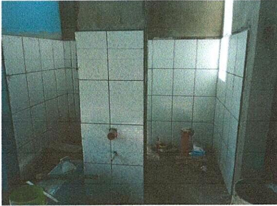
Foto 1: Mejoramiento e instalación de servicio sanitario para el nivel preprimario.
